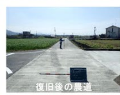
復旧後の農道
