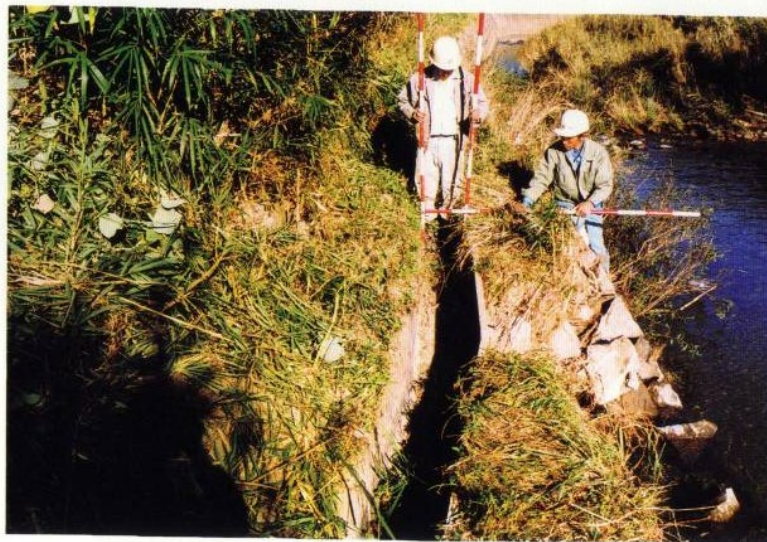
写真 2-12-5 水路の断面写真
