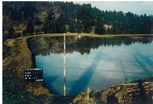
(心土練り直し、転圧、水整地により復旧)
