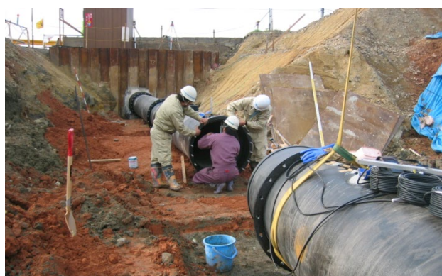
写真 4-5-1 柔構造底樋の施工状況
