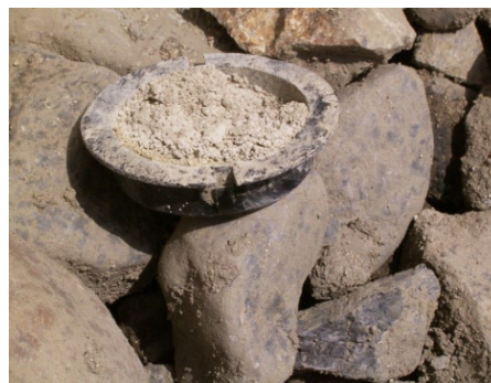
フィルタ内固結状況
