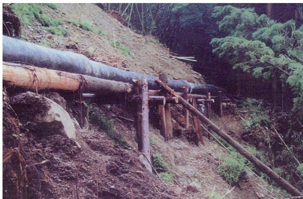
写真 12-2-3 用水路の応急仮工事
