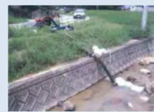
仮設ポンプを設置し、用水を確保
