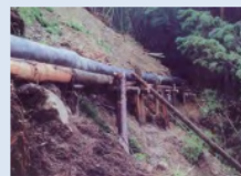
仮設水路を設置し、用水を確保
