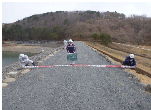
写真 12-2-2 増破防止工事完了後のため池
