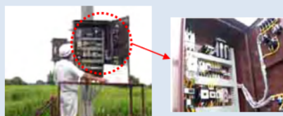
浸水した揚水機場の制御盤の部品を交換することによりポンプ機能を回復
