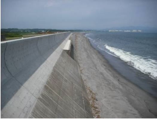
堤防整備状況
