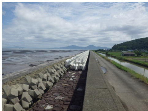
消波ブロック整備状況
