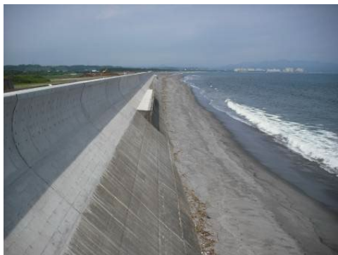
堤防整備状況
