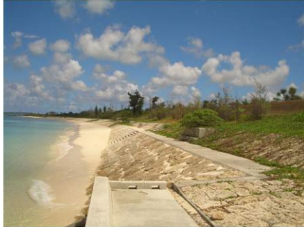
緩傾斜護岸整備状況
