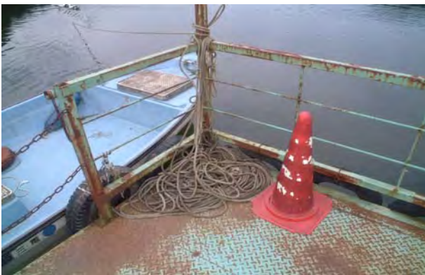
救出用安全ロープの常時設置
