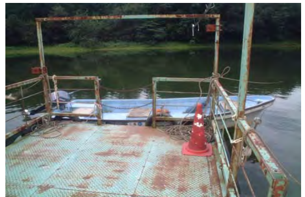
救命用ボートの常時設置
