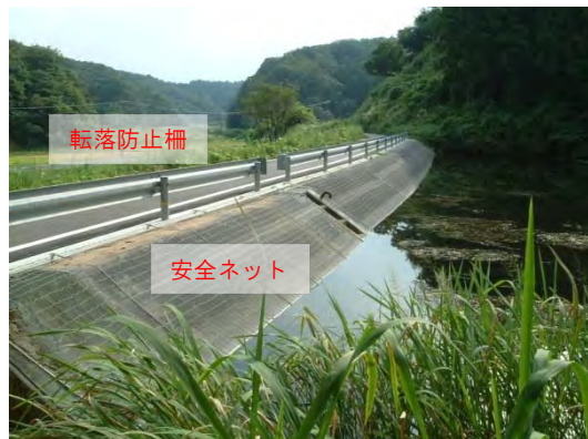
堤体法面に設置した安全ネット
