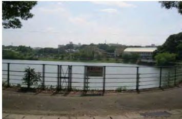
転落防止柵・警告看板の設置
