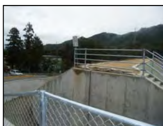
警告看板の設置
