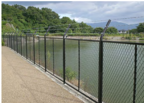
防護柵の設置
