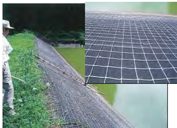
安全ネットの設置
