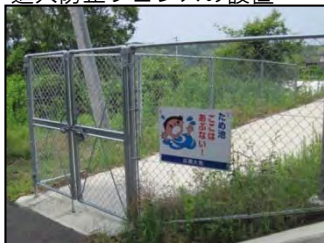
進入防止フェンスの設置
