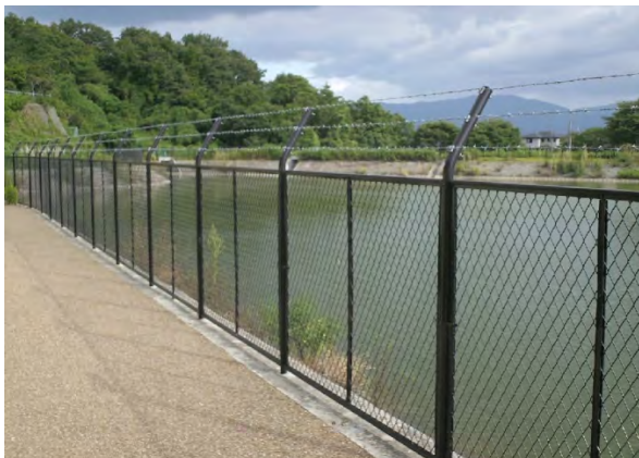
防護柵の設置
