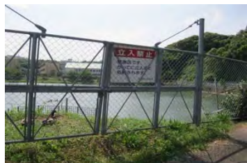
転落防止柵・警告看板の設置
