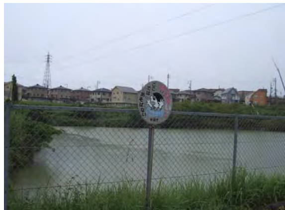
警告看板の設置③
