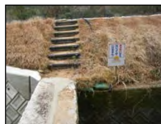
警告看板の設置
