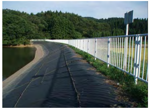
堤体法面に安全ロープの設置
