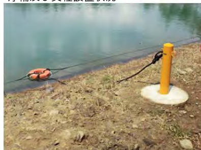
浮輪及び支柱設置状況
