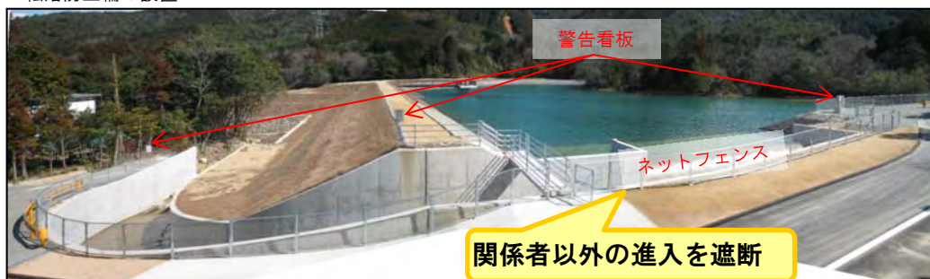
転落防止柵の設置
