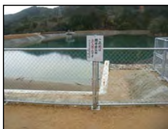
警告看板の設置
