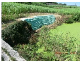
土のうによる崩落箇所の拡大防止
