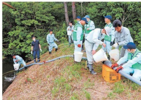
簡易型排水装置の普及に向けて岡山県が開いた研修会。堤防上の接続部から水を注いでホース内を満たす＝6日、岡山市内
