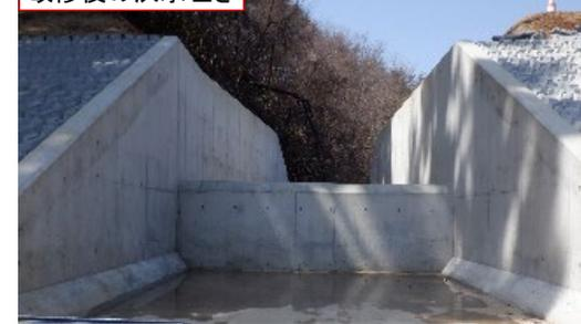
洪水流下能力が約3倍に向上(約 $9\text{m}^3/\text{s}$ )
