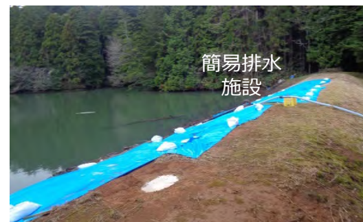
被災箇所をブルーシートで保護 簡易排水施設により水位を低下
