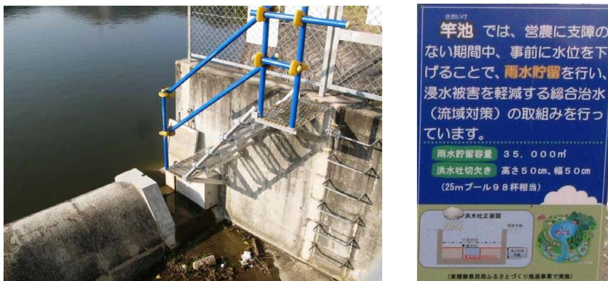
図5.3.1：スリット（切欠き）と作業階段が設置されたため池（高砂市阿弥陀地区竿池）
