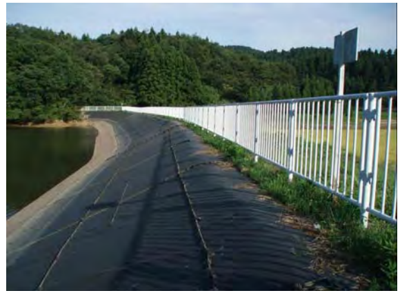
堤体法面に安全ロープの設置
