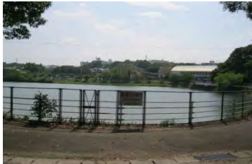
転落防止柵・警告看板の設置
