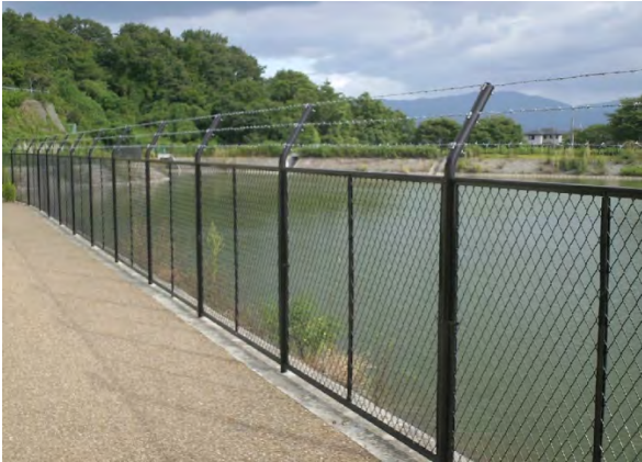
防護柵の設置
