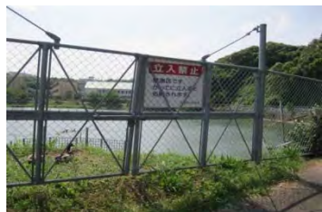
転落防止柵・警告看板の設置
