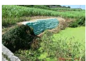
土のうによる崩落箇所の拡大防止
