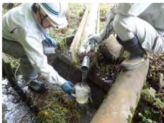
堤体からの漏水量計測
