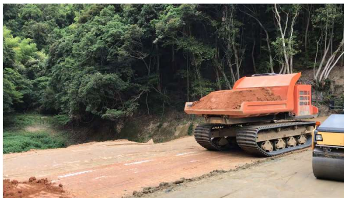
刃金土運搬状況(福岡県土連HPより)
