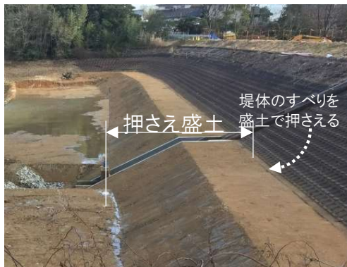
改修後(押さえ盛土による補強)
