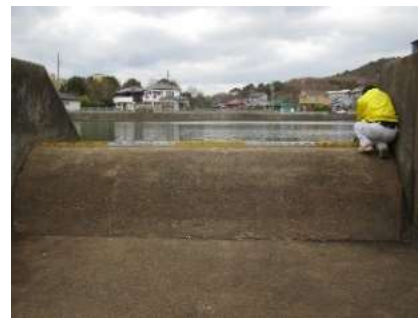
豪雨に対する詳細調査 (洪水吐の構造を調査)
