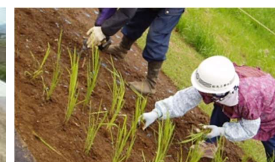
改修後に堤体法面へ植付け
