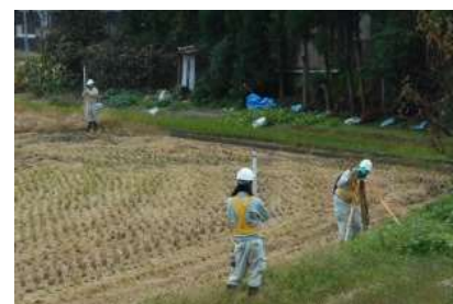
レベルによる出来形測定
