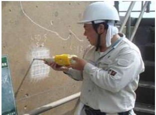
老朽化した施設の機能診断
