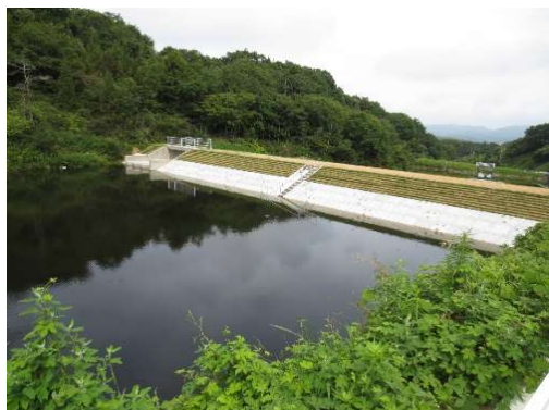
改修後(法面保護による侵食防止)
