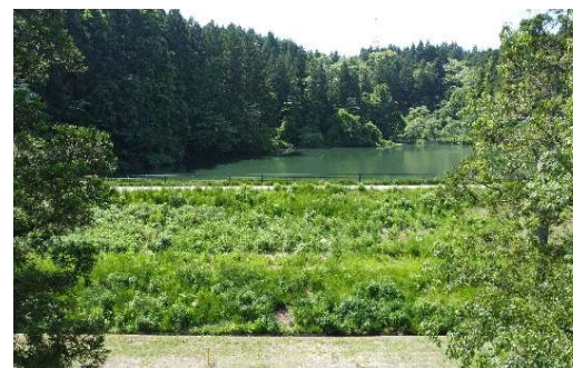
改修後のため池堤体法面
