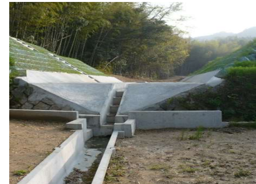
堤体の一部撤去(下流側より)
