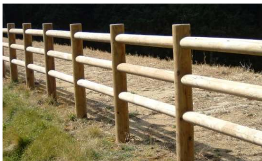
自然材料を活用した安全施設
