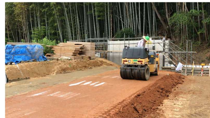
刃金土転圧状況(福岡県土連HPより)
