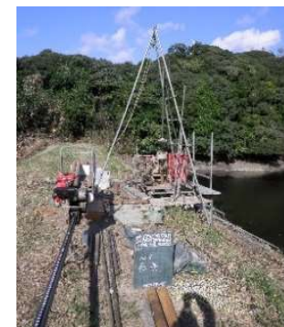
地震に対する詳細調査 (ボーリングによる土質調査)
