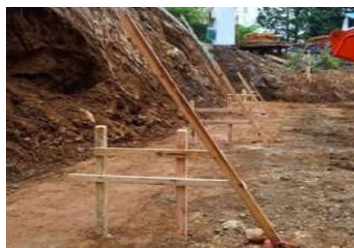
設計図に合わせて丁張り設置
