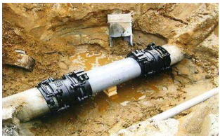
漏水防止のための整備
