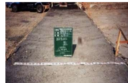
巻尺による出来形測定
