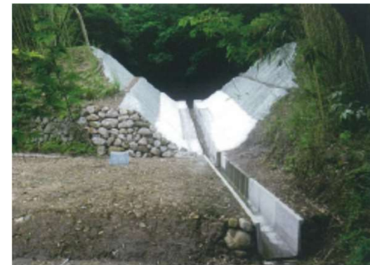
堤体のV字カット(下流側より)
