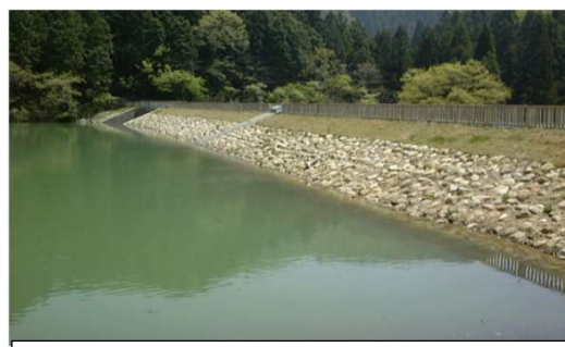
自然石を用いた護岸
