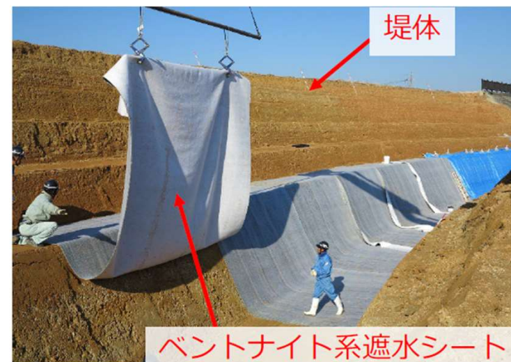
敷設状況(農研機構HPより)
