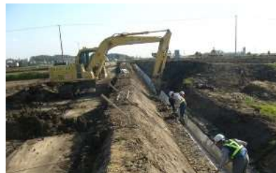
丁張りに合わせて施工
