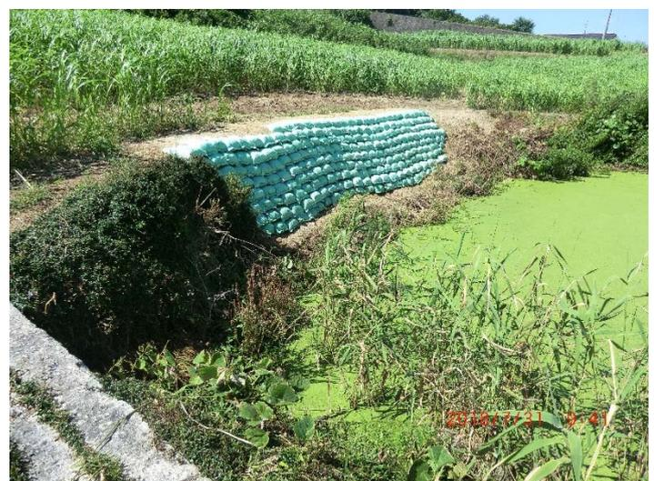
【例⑤】土のうによる崩落箇所の拡大防止
