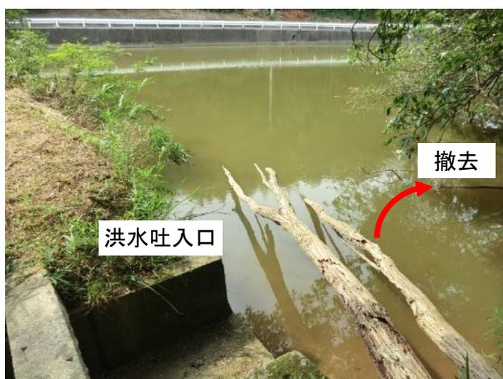
【例④】洪水吐に堆積した土砂や流木等の撤去
