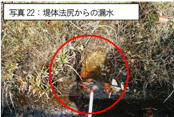
図 16：小段承水路の堆砂、堤体下流法面からの水の浸み出し
