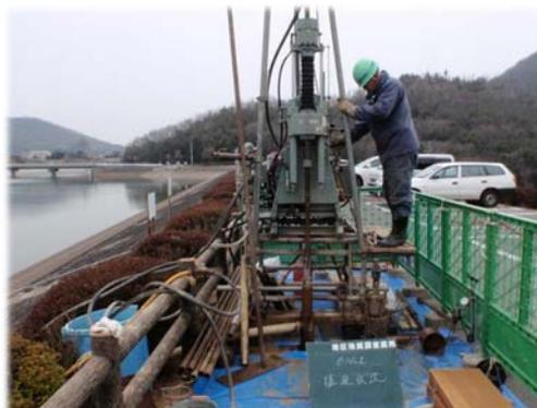
写真2. 2：地震に対する安定性の調査（堤体のボーリング調査）
