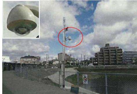
写真2. 4：観測機器の設置（監視カメラ）
