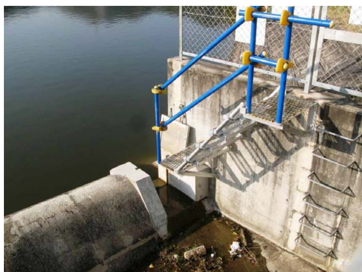
図5. 3. 1：スリット（切欠き）と作業階段が設置されたため池（高砂市阿弥陀地区竿池）
