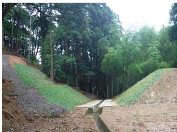
写真-3.2 開削工法によるため池の廃止事例 2
