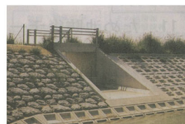
洪水吐き周辺の状態確認
