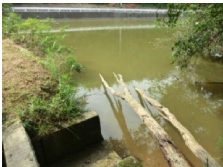
写真１ 洪水吐き流入部に流れ着いた流木
