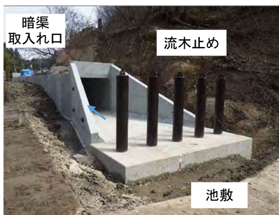
写真-5.3.1 暗渠上流側の流木止め設置例
