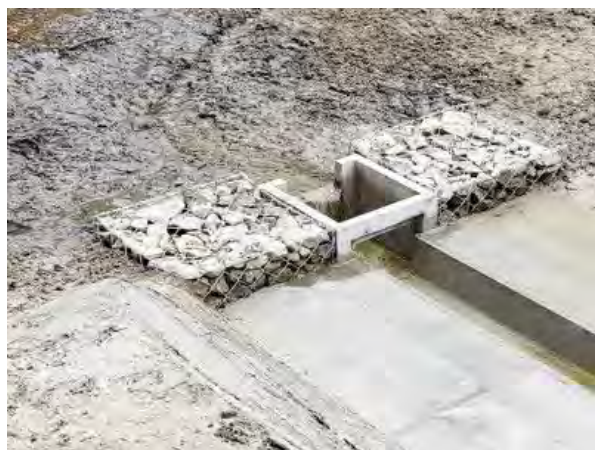
写真-4.5.2 集水樹の設置事例
