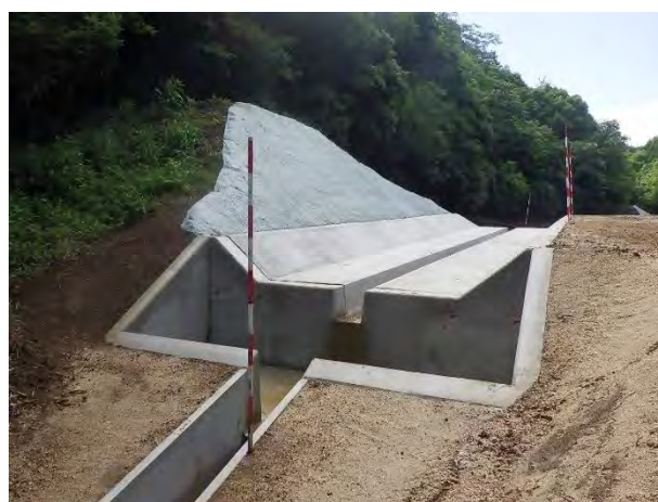
写真-4.5.3 接続桝の設置事例
