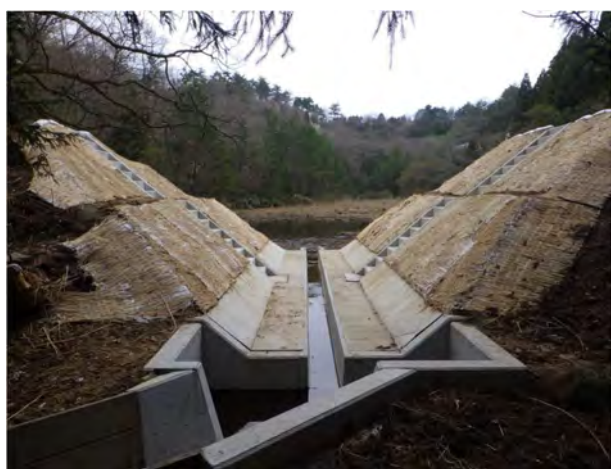
写真-4.5.3 接続桝の設置事例
