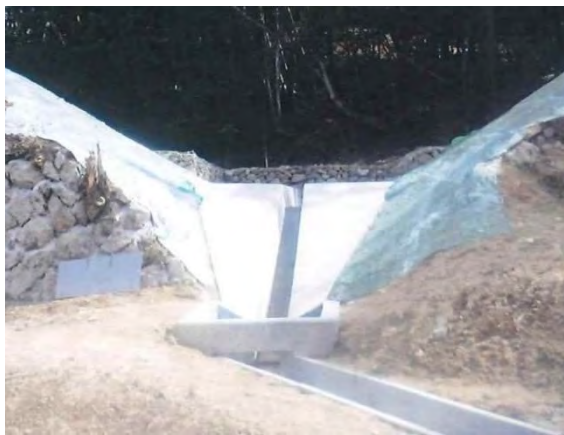
写真-4.5.4 急流工の設置事例
