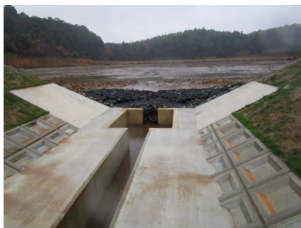
写真-4.5.2 集水樹の設置事例
