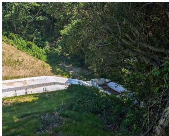
写真-4.5.4 急流工の設置事例
