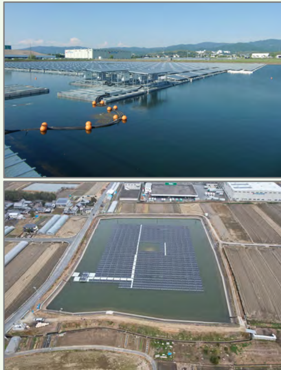
▲水上太陽光発電設備の設置状況
