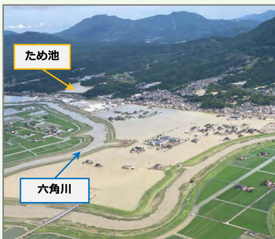
▲豪雨による被災状況
