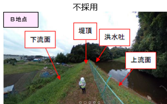
監視カメラからの画角確認の様子 2地点を比較した上で、洪水吐きに近い A地点を選定（仙台市）
