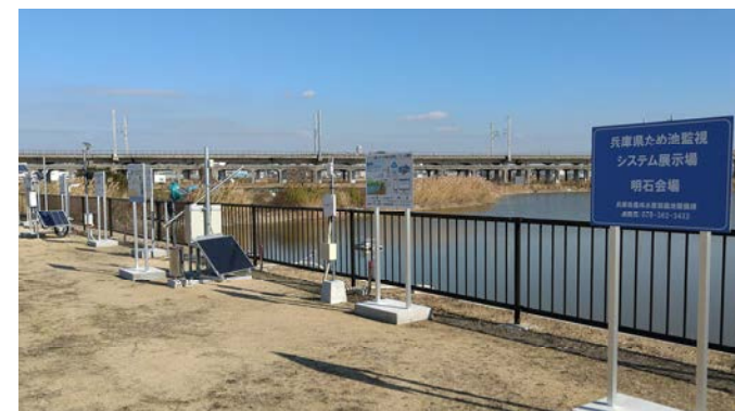
▲ため池監視システム展示場（兵庫県）
