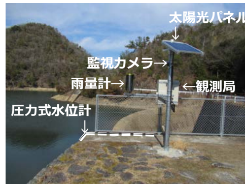
農業用ため池遠隔監視機器の設置状況（和気町）
