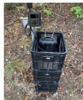
③蓄電池のかさ上げ
