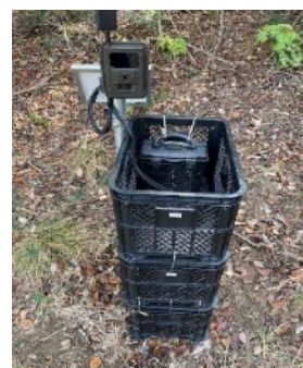
③蓄電池のかさ上げ
