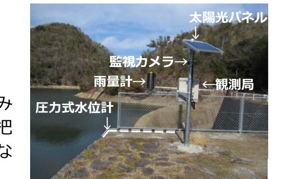
農業用ため池遠隔監視機器の設置状況（和気町）
