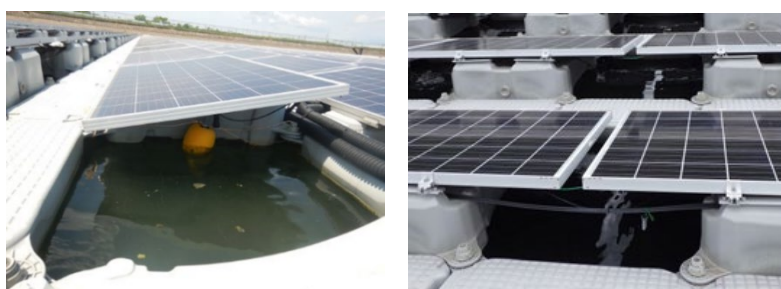
図 3.3 (2) 気温計の設置状況
