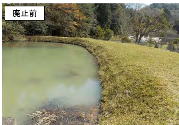
写真-3.7 堤体開削工法と埋立法の複合工法の事例
