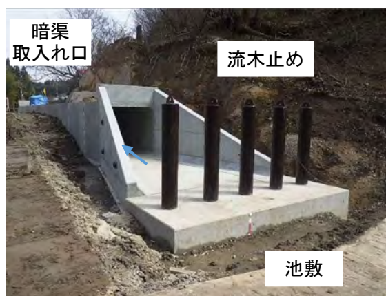
写真-5.3.1 暗渠上流側の流木止め設置例
