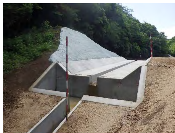
写真-4.5.3 接続桝の設置事例
