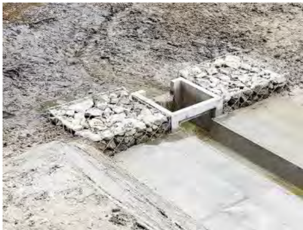
写真-4.5.2 集水樹の設置事例
