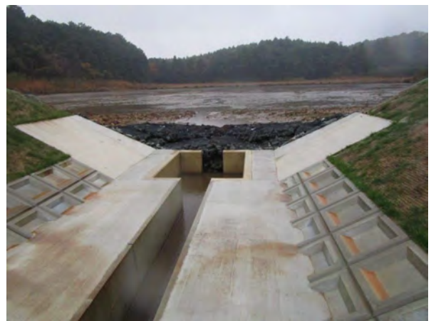
写真-4.5.2 集水樹の設置事例
