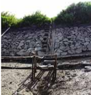
昔の取水施設
