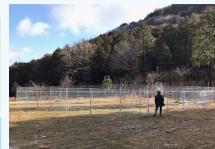
リモートアップゲート防護柵
