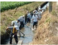
水路の泥上げ
