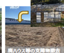
【荒廃農地の支障物撤去】
