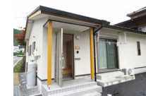
空き家の改修 （お試し居住施設）
