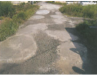
農道の窪みの補修
