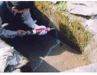
水路のひび割れ補修
