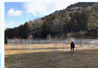
リモートアップゲート防護柵
