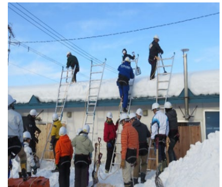
雪下ろし実技講習
