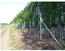
強固な侵入防止柵
