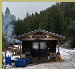
処理加工施設 外観
