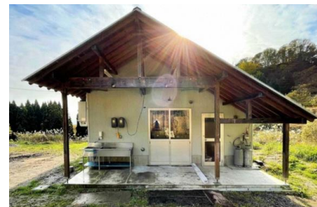
＜処理施設の外観＞
