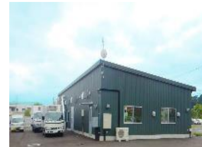
<処理施設の外観>
