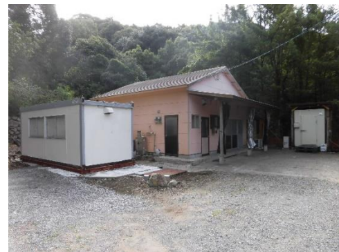
＜処理施設の外観＞
