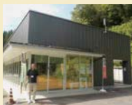
長野市ジビエ加工センター
