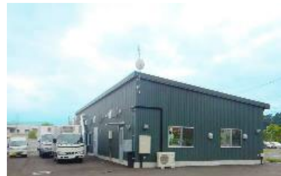
<処理施設の外観>
