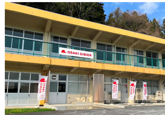
<処理施設の外観>
