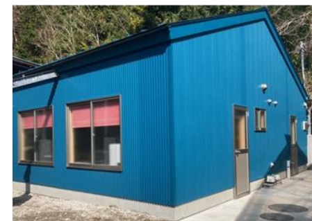
＜処理施設の外観＞
