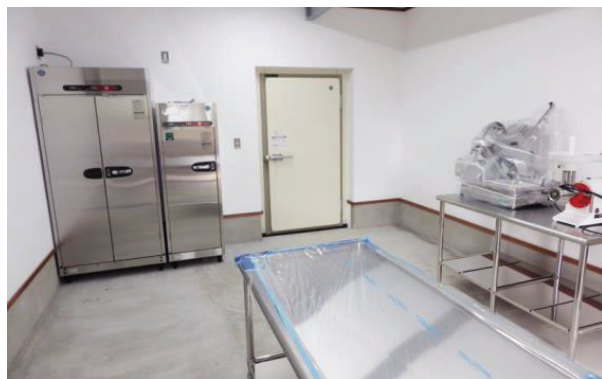
<処理施設の内部>
