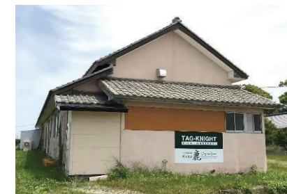
<処理施設の外観>
