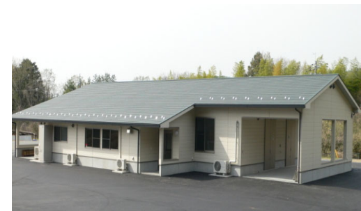
<処理施設の外観>
