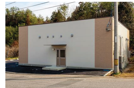
<処理施設の外観>
