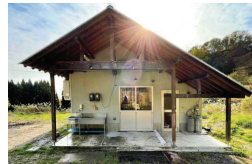
＜処理施設の外観＞
