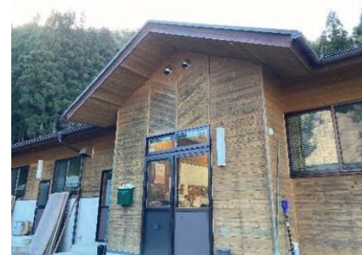
＜処理施設の外観＞
