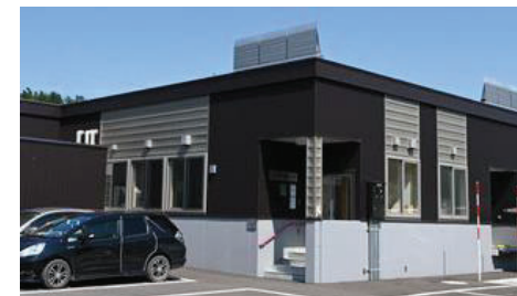
<処理施設の外観>
