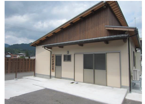
<処理施設の外観>
