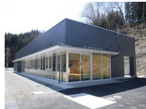
<処理施設の外観>
