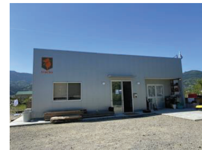
<処理施設の外観>
