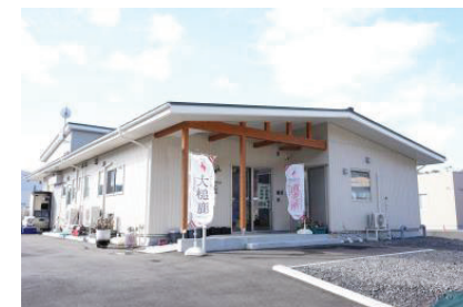
<処理施設の外観>
