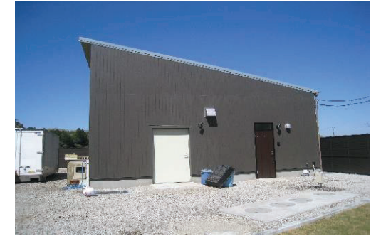
<処理施設の外観>
