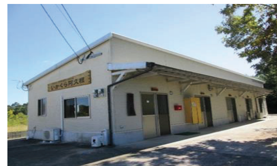
<処理施設の外観>
