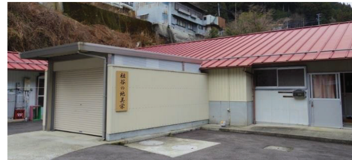
<処理施設の外観>
