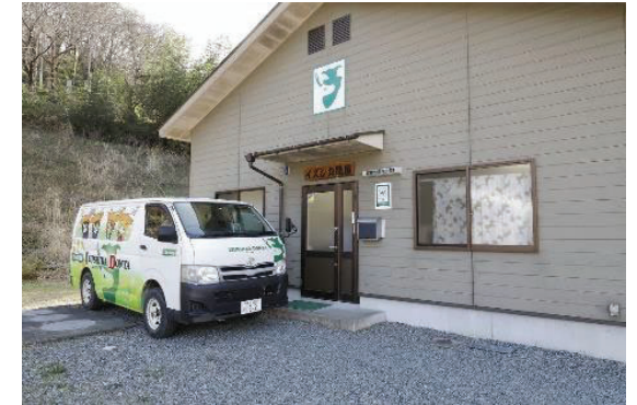
<処理施設の外観>
