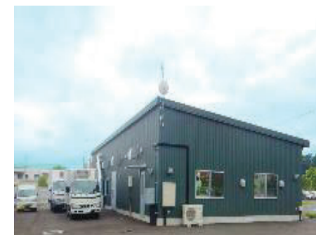
<処理施設の外観>
