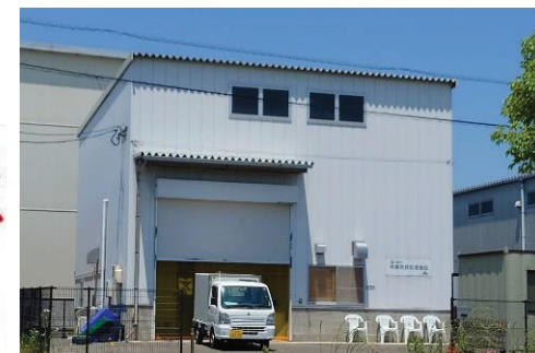
<処理施設の外観>
