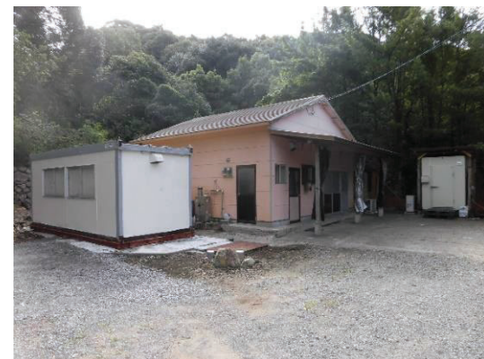
<処理施設の外観>
