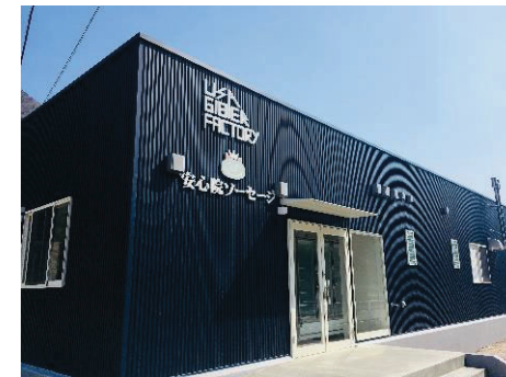
<処理施設の外観>
