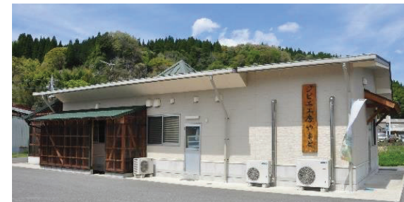
<処理施設の外観>
