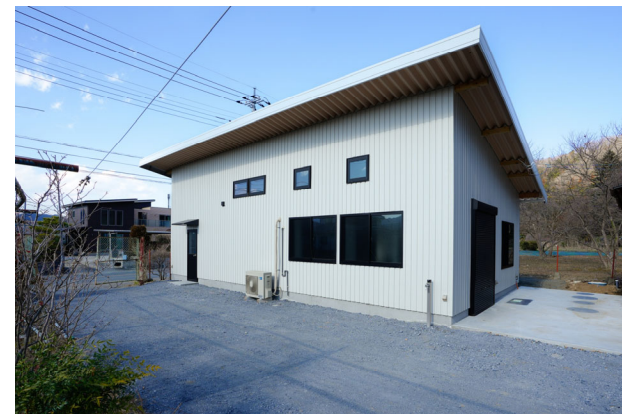
<処理施設の外観>
