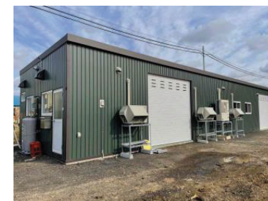
<処理施設の外観>
