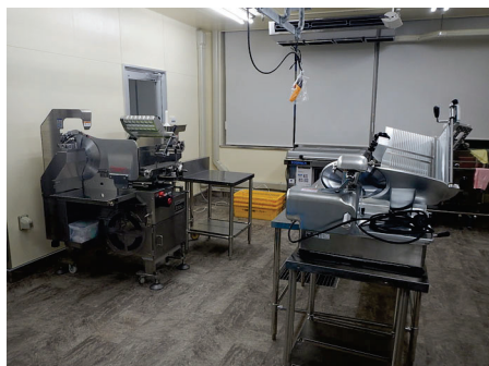
<処理施設の内部>
