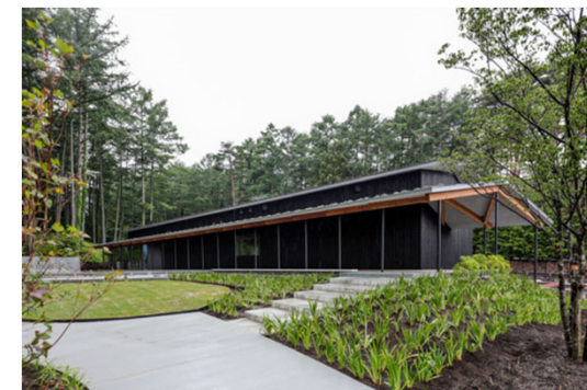
<処理施設の外観>
