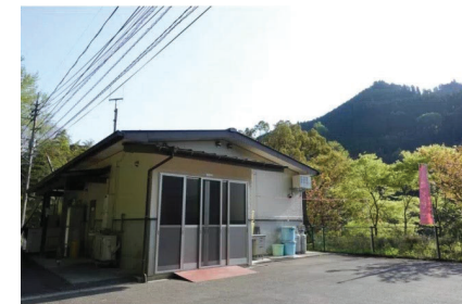
<処理施設の外観>
