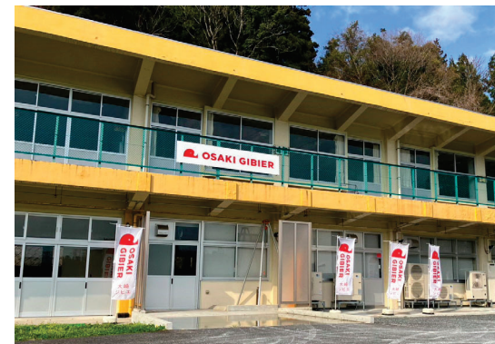
<処理施設の外観>
