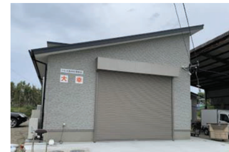
＜処理施設の外観＞
