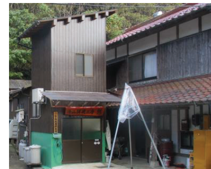
<処理施設の外観>
