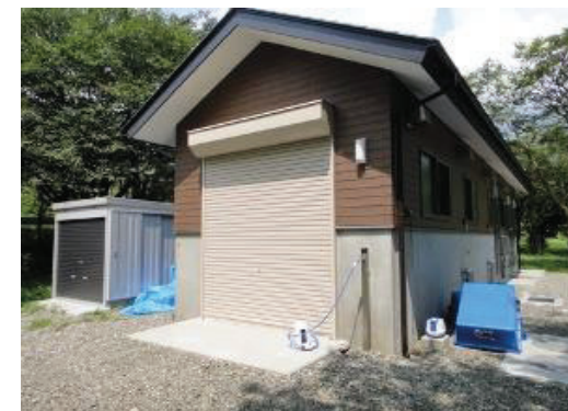
<処理施設の外観>
