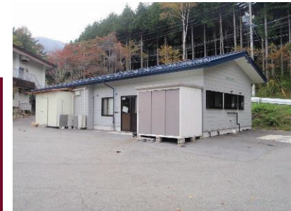
<処理施設の外観>
