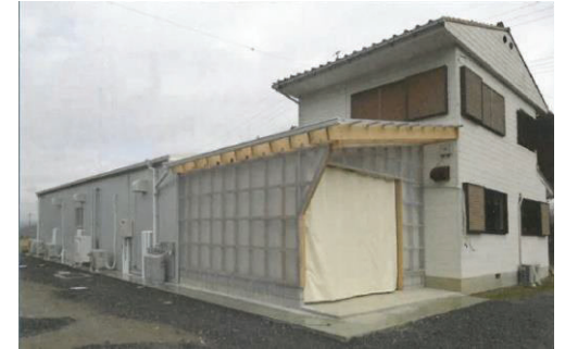
＜処理施設の外観＞
