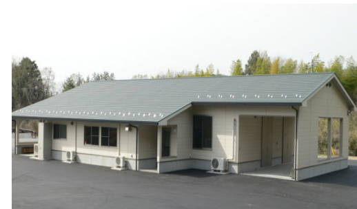
<処理施設の外観>
