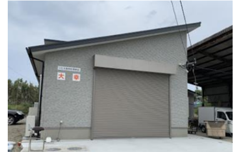
<処理施設の外観>
