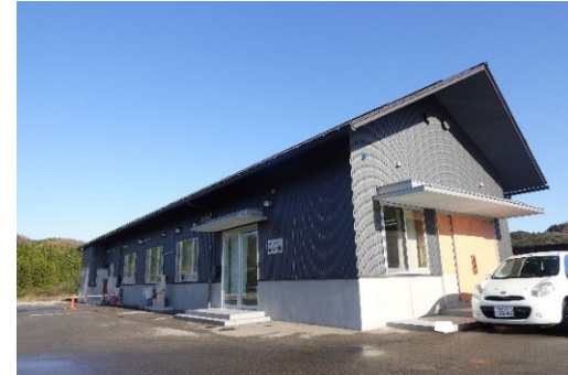
<処理施設の外観>
