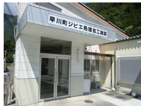
<早川町ジビエ処理加工施設>
